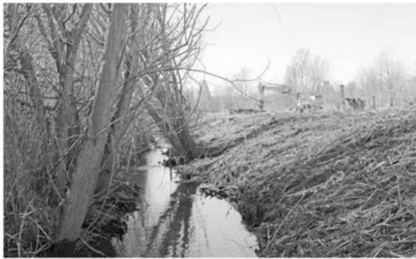
Beginn der Renaturierungsmaßnahmen am Eulenbach Foto Norbert Sauren
